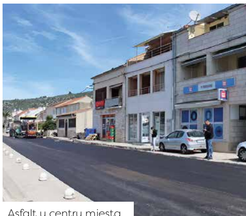
Asfalt u centru mjesta
